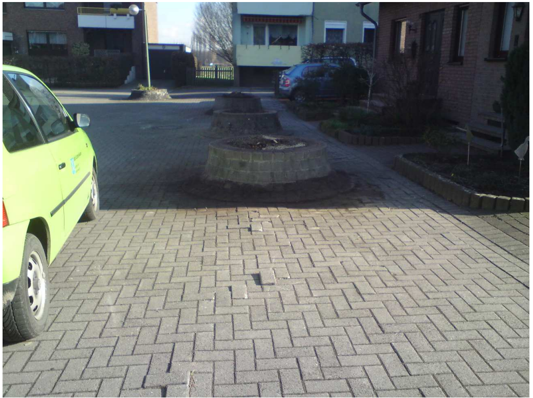
Stolperkanten im Pflaster
