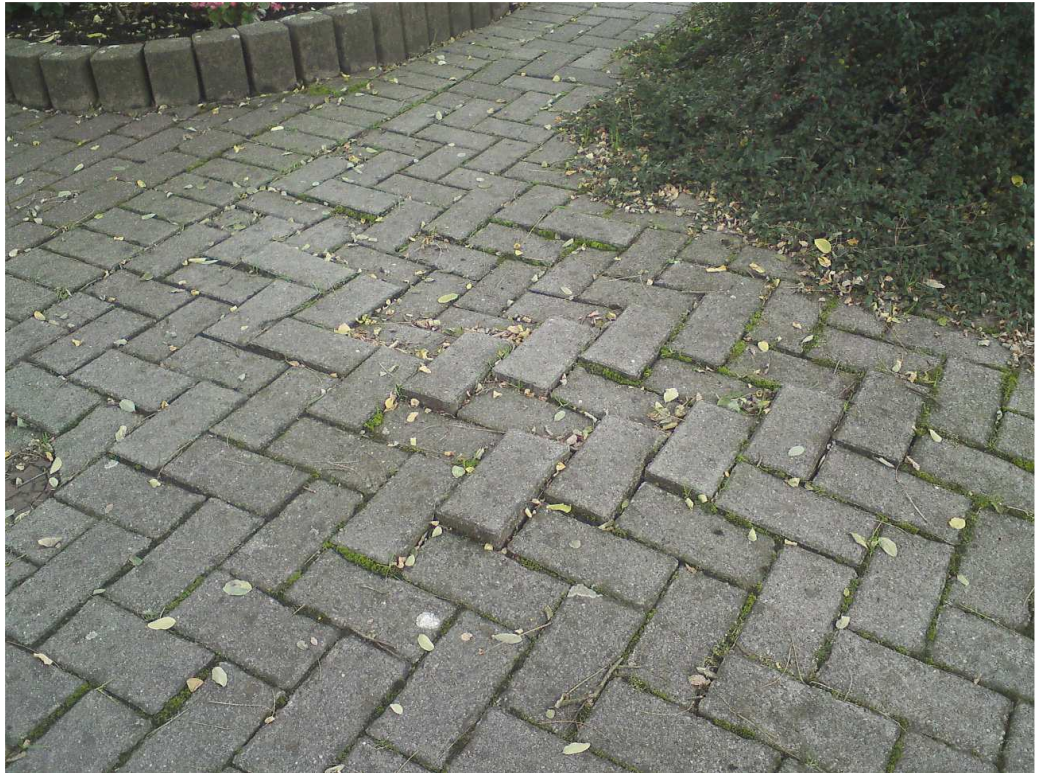
Detail Pflaster in diesem Bereich
