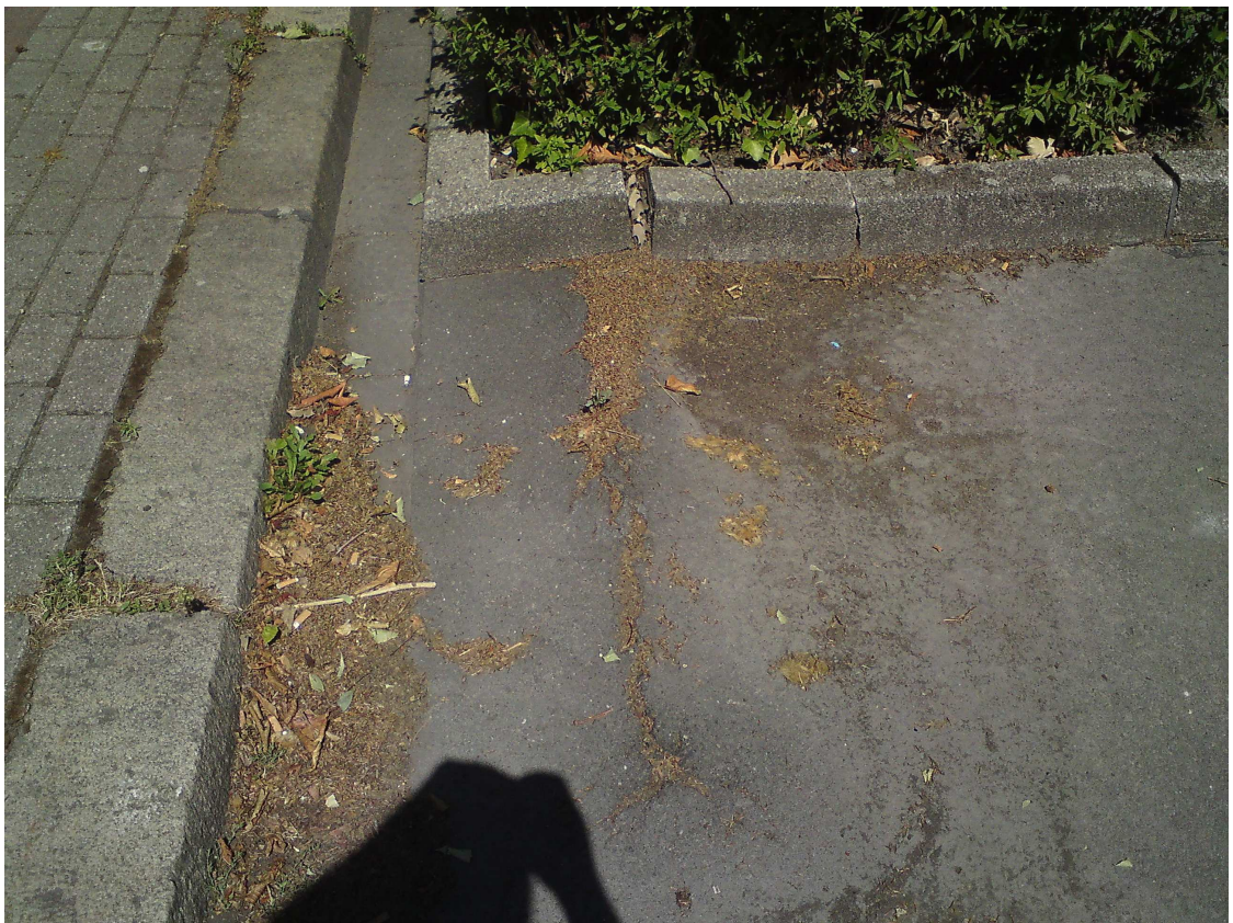
Wurzelverlauf bis unter den Asphalt
