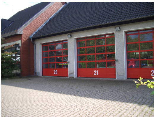
Fahrzeughalle LZ 1 Castrop
