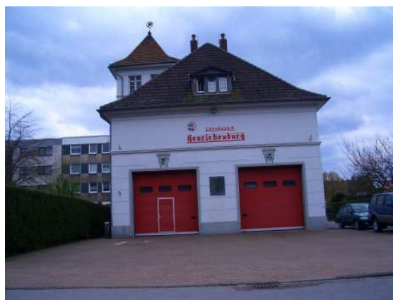
Gerätehaus LZ 4, Hedwig-Kiesekamp-Straße
