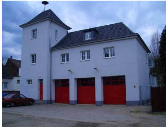
Gerätehaus LZ 3, Dornbachstraße
