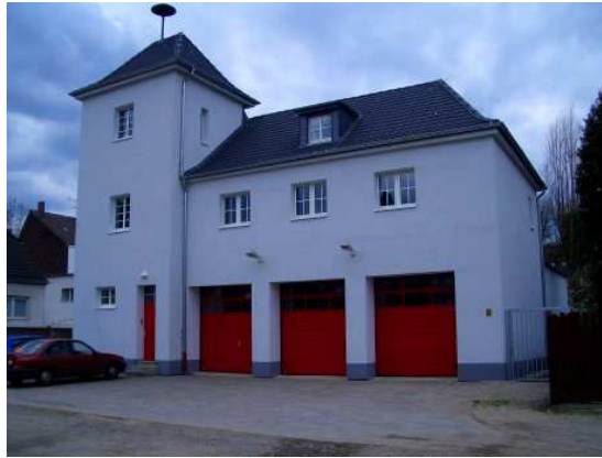
Gerätehaus LZ 3, Dornbachstraße
