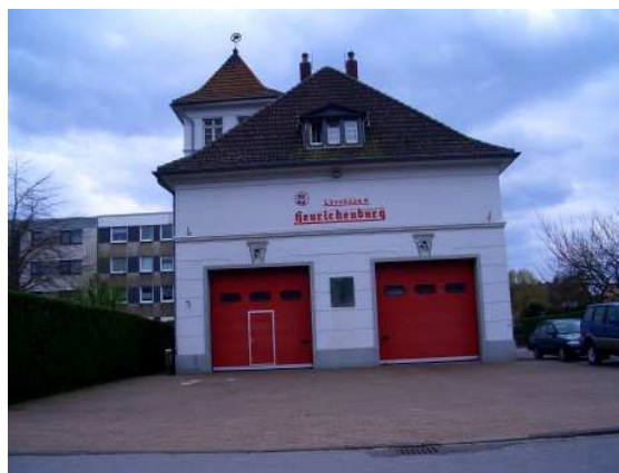
Gerätehaus LZ 4, Hedwig-Kiesekamp-Straße
