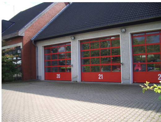
Fahrzeughalle LZ 1 Castrop
